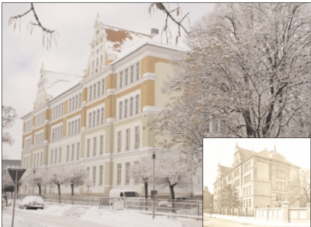
Farbenfroh: die sanierte Zetkin-Schule (gr. Foto). 1902 war das Gebäude (kl. Foto) als Knabenbürgerschule eröffnet worden, heute zählt die Schule zu den modernsten der Stadt. Foto: PS/ Postkarte: Stadtarchiv
