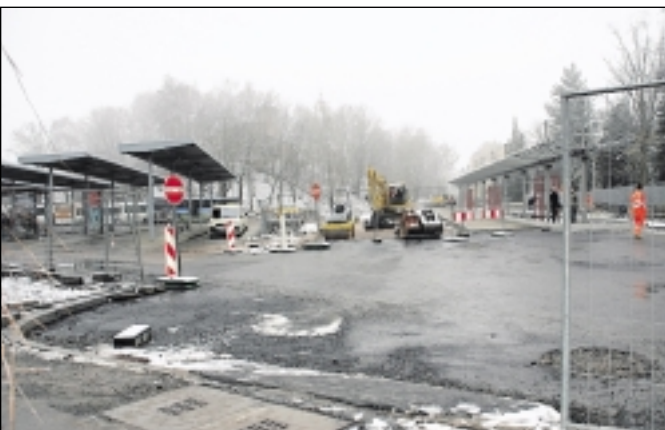
Der Busbahnhof am Roten Weg. Hier haben in dieser Woche die Bauarbeiten begonnen. Ende Oktober soll der neue Busbahnhof fertig sein. Foto: Sina Heinze
