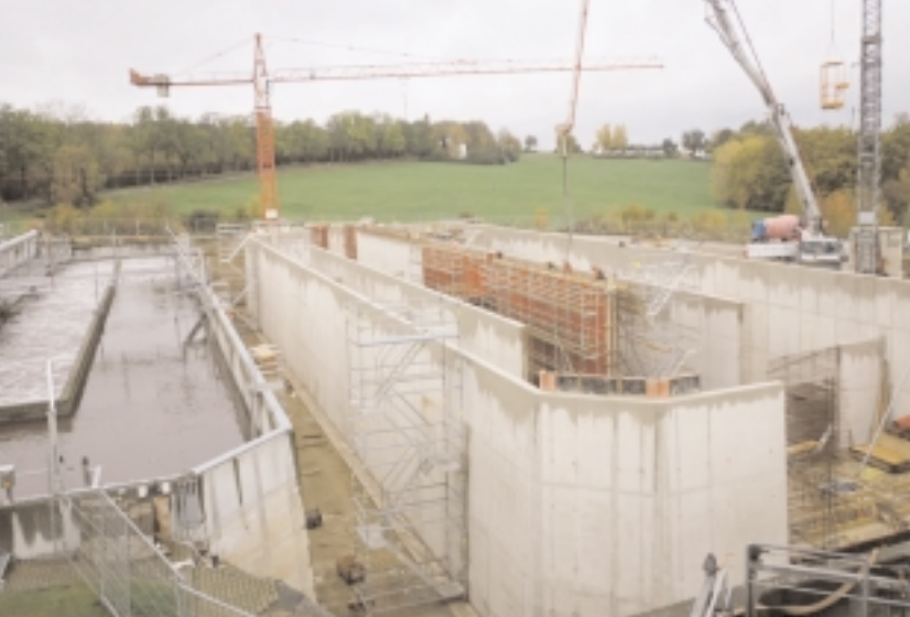
Der Neubau des Belebungsbeckens der Zentralkläranlage.
