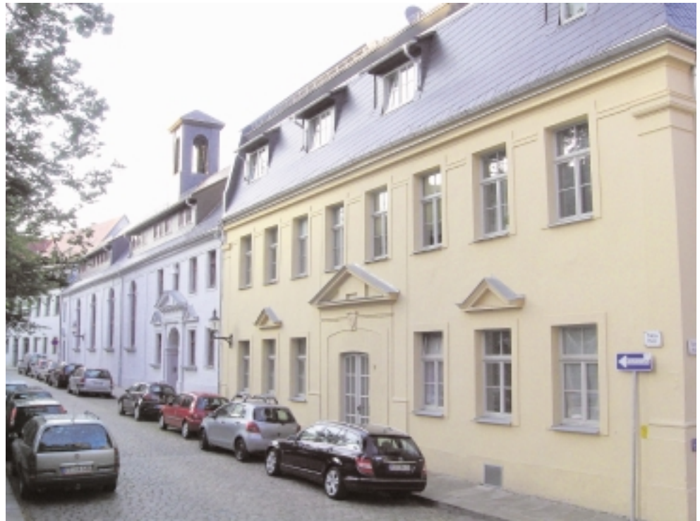
Kreuzgasse 1/3: Die Idee, den Komplex der ehemaligen katholischen Kirche zu einer Eigentumswohnanlage umzubauen, wird mit dem Sanierungspreis der Stadt Freiberg 2010 honoriert.
