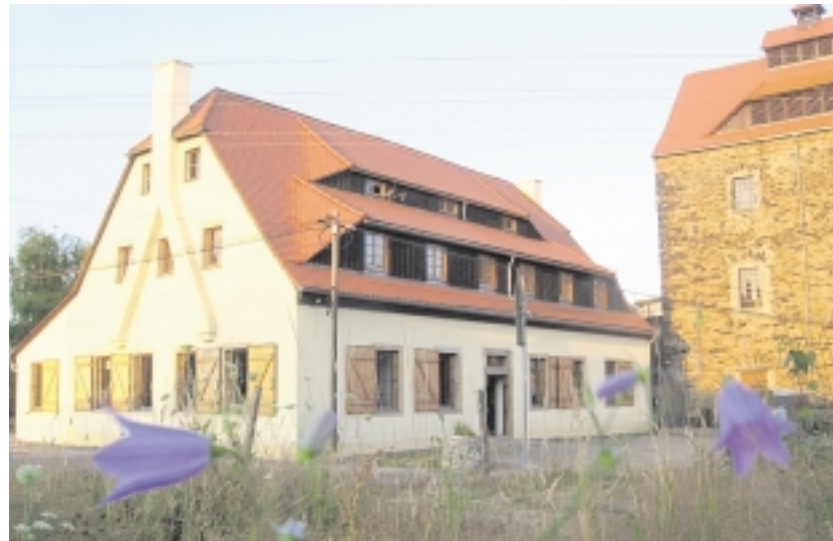
Ehemalige Bergschmiede Abrahamschacht, Schachtweg 14
