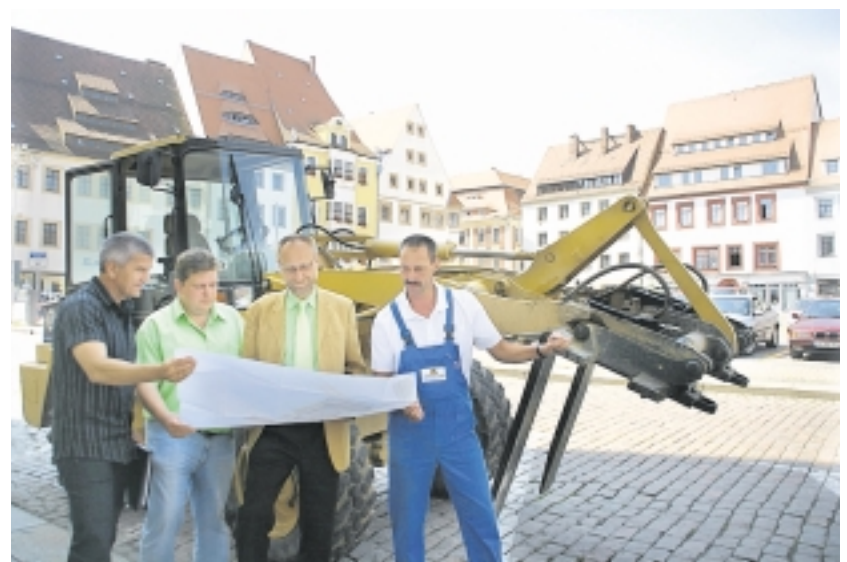
Bevor es richtig losging mit der Sanierung des Obermarktes: Bauberatung vor Ort – hier mit Bürgermeister Holger Reuter (2.v.r.). Foto: PS
