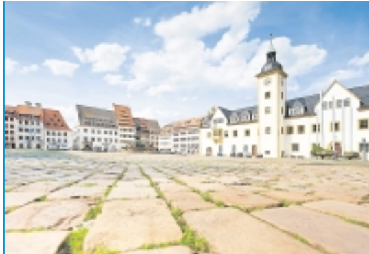
Der „alte“ Freiberg Obermarkt. Seine Sanierung hat in diesem Jahr begonnen, der erste Bauabschnitt ist beendet. Im kommenden Frühjahr geht es weiter: Dann wird der Marktspiegel seine neue Gestalt bekommen. Eingeweiht wird der neue, alte Platz im Herzen der Stadt zum 27. Christmarkt im November 2011. Fotos (2): René Jungnickel
