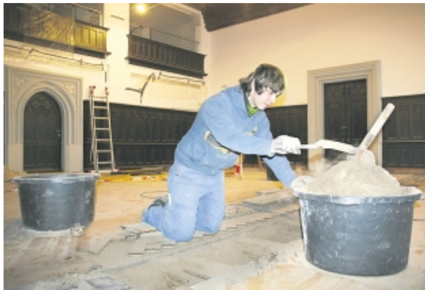
Der Ratssaal im Rathaus: Hier wo sonst die Stadträte ihre Entscheidungen für die Stadt treffen, wird derzeit kräftig gebaut: Ricardo Hendel von der elektro union ist gerade dabei einen Kabelschacht fürs Verlegen der Medientechnik auszuheben. Foto: PS
