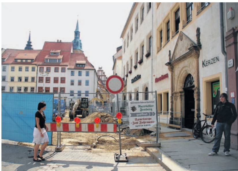
Derzeit kein Durchkommen mehr am Obermarkt. Sowohl von der Waisenhausstraße wie von der Weingasse aus prangt eine Vollscheibe. Denn wegen notwendiger Kanal- und Trinkwasserleitungsbauarbeiten ist die Zufahrt von der Waisenhausstraße voll gesperrt – voraussichtlich bis Mitte August. Foto: PS
