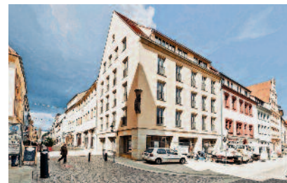
Das Dürer-Haus am Obermarkt - nun frisch saniert. Foto: SWG
