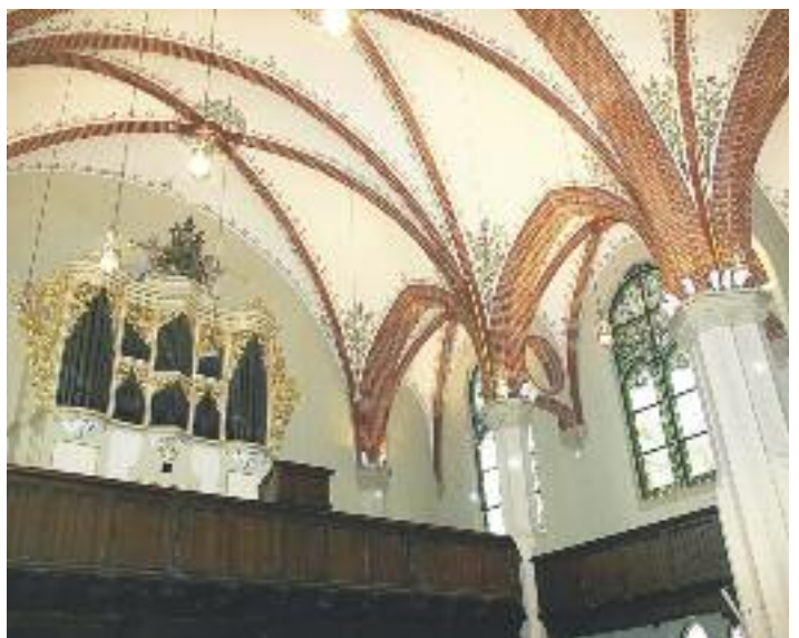
Jakobikirche: Führungen im frisch restaurierten Gotteshaus. Das reich im Stil des Historismus ausgestattete Gebäude ist mit seiner wiederhergestellten floralen Flankenmalerei besonders sehenswert.
