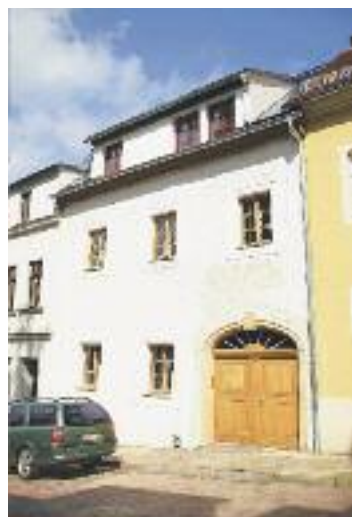
Donatsgasse 21: Hier gibt es Interessantes zur Geschichte des Hauses und Sanierung zum Null-Energiehaus.
