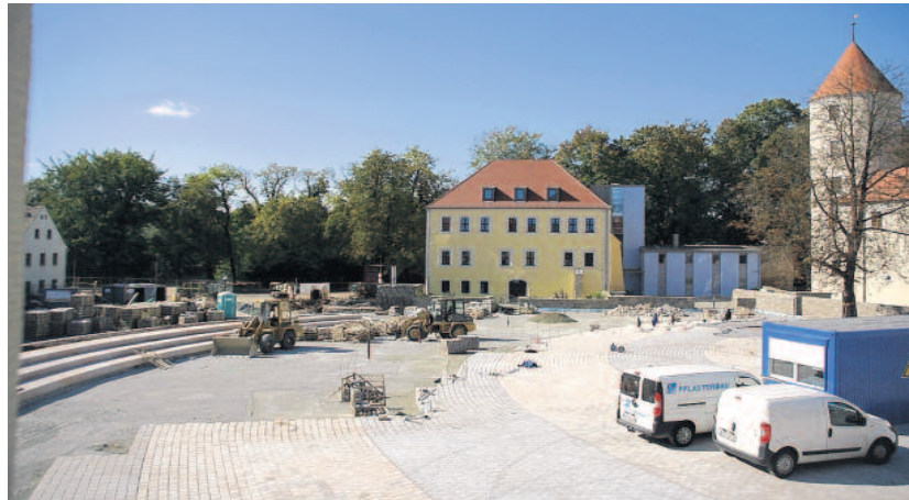
Endspurt auch auf der Baustelle vor Schloss Freudenstein: Schon jetzt lässt sich erahnen wie der Schlossplatz mit seinen neuen Sitzpodesten und der Pflastergestaltung zur geplanten Fertigstellung Mitte November aussehen wird. Foto: PS
