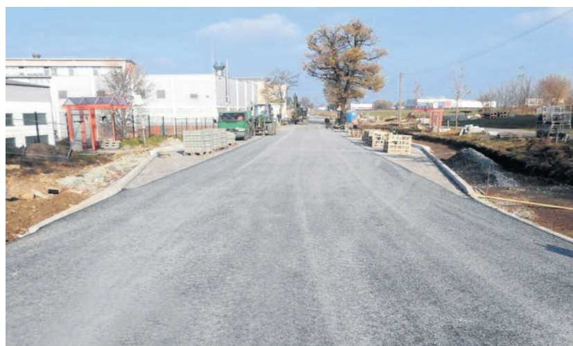
Endspurt auf der Baustelle: Herstellung der Busbuchten im Bereich zwischen DBI und AcTech, Blickrichtung stadtauswärts. Foto: Chemnitzer Ingenieurbau Consult GmbH
