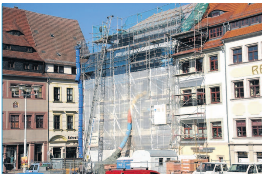
Nicht zu übersehen: die Bautätigkeit am Gebäude Obermarkt 21. Im Mai 2012 soll es fertig sein. Foto: Anett Stromer
