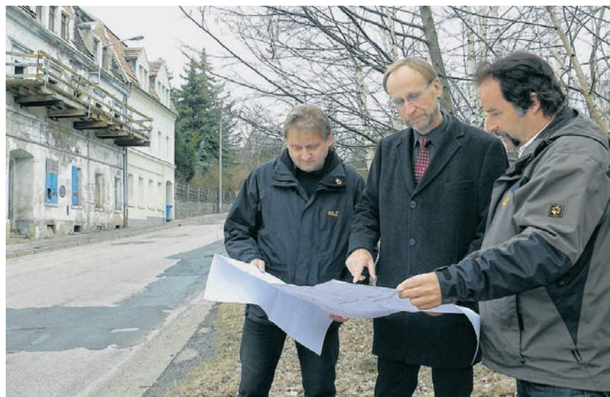
Letzte Absprache vor dem Baubeginn: Bürgermeister Holger Reute (Mitte) vor Ort mit Tiefbauamtsleiter Tom Kunze (L.) und Tiefbauamtsmitarbeiter Rolf Rothermundt, Bauleiter für die Maßnahme Halsbrücker Straße.
