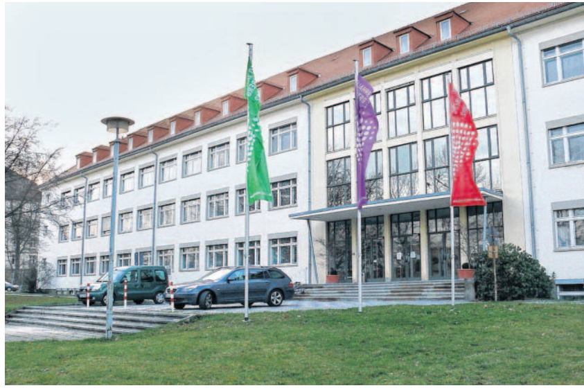
Das Haus an der Chemnitzer Straße Nummer 40: Den meisten Freibergern ist es landläufig noch als „FIA“ bekannt. Hier soll künftig das Helmholtz-Institut Freiberg für Ressourcentechnologie seinen Sitz haben. Dafür wird es jetzt saniert. Foto: CLW
