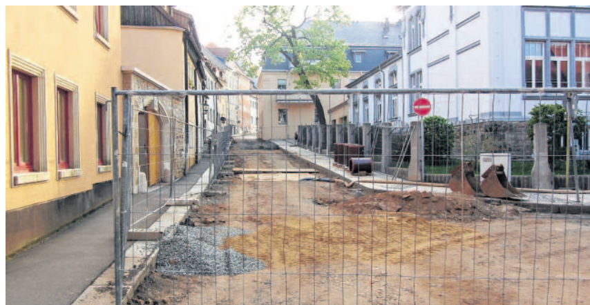
Noch bis Ende Oktober wird hier gebaut.
