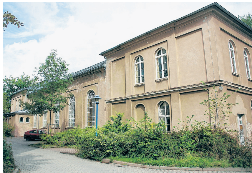
Die älteste Turnhalle Freibergs: die Jahn-Sporthalle in der Turnerstraße. Sie soll jetzt saniert werden. Foto: PS
