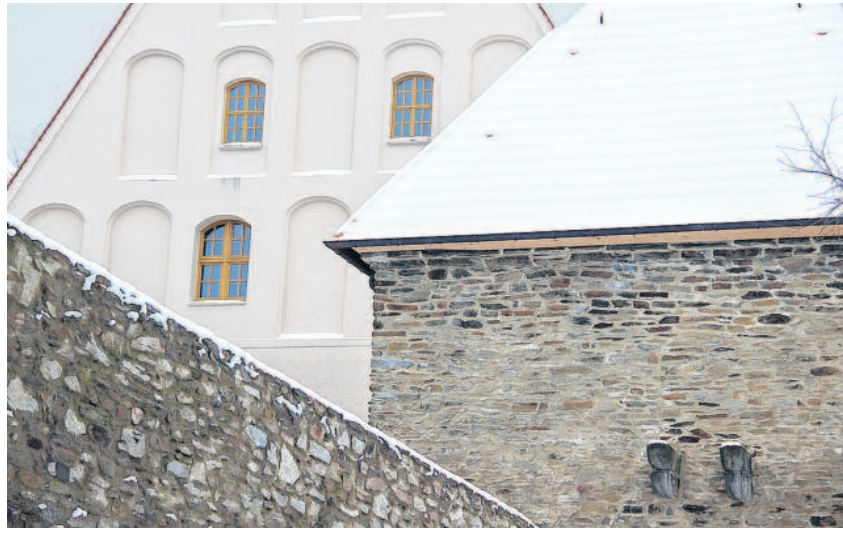
Das Kornhaus hebt sich mit seiner frisch sanierten Außenhülle deutlich von der Stadtmauer ab. Nun soll auch das Innenleben des historischen Gebäudes erneuert werden. Fotos: PS
