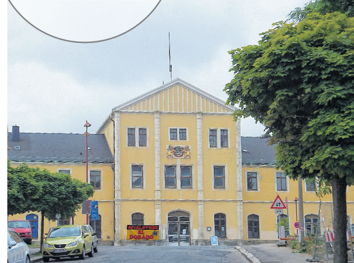
Eine thematische Führung zum Motto des Denkmaltags führt zu einigen Freiburger Objekten, die wegen ihres Zustands immer wieder auf Unverständnis stoßen – wie beispielsweise der Bahnhof. Die Führung beginnt 10 Uhr an der Kurt-Eisner-Straße am Seilerberg.
