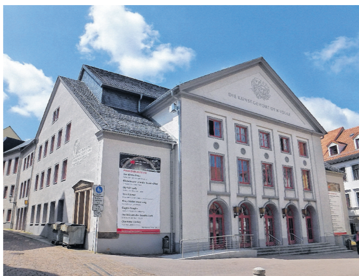
Das Stadttheater Freiberg wurde nach der Eröffnung 1790 mehrfach erweitert und umgebaut und nimmt heute mit dem Hauptgebäude am Buttermarkt, Werkstätten, Ateliers, Büros und Proberäumen einen ganzen Häuserblock ein.
