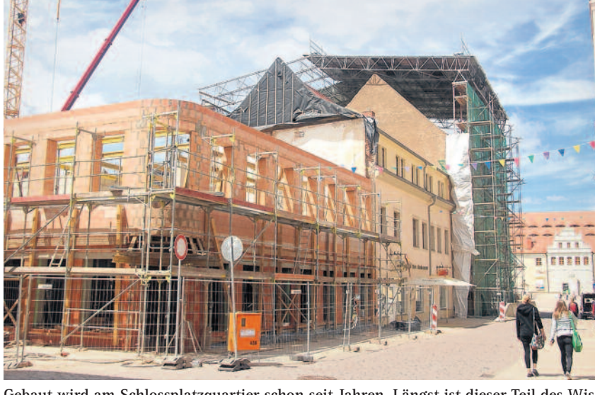
Gebaut wird am Schlossplatzquartier schon seit Jahren. Längst ist dieser Teil des Wissenschaftskorridores Gegenstand vieler Diskussionen.
