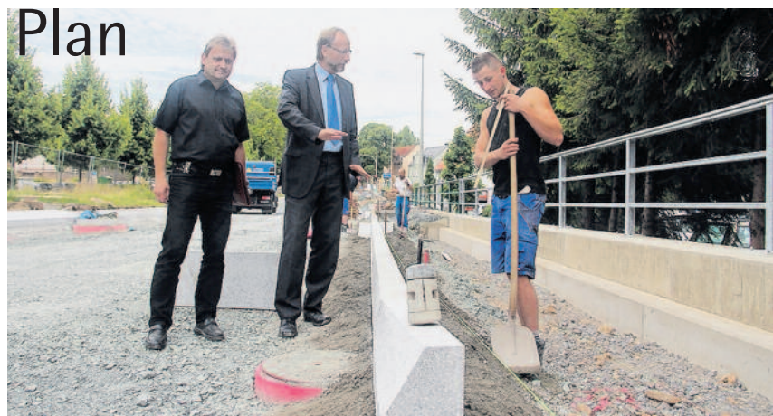
Bürgermeister Holger Reuter (Mitte) und Tiefbauamtsleiter Tom Kunze unterwegs auf den Freiburger Baustellen. Hier informieren sie sich über den Stand der Bauarbeiten auf dem Meißner Ring/Donatsring. Mit im Bild: Straßenbau-Azubi Danny Schubert. Foto: PS
