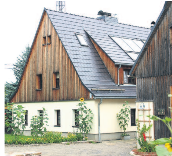
Schulstraße 10 (OT Zug)
