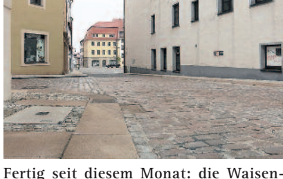
Fertig seit diesem Monat: die Waisenhausstraße, Zufahrt zum Obermarkt.
