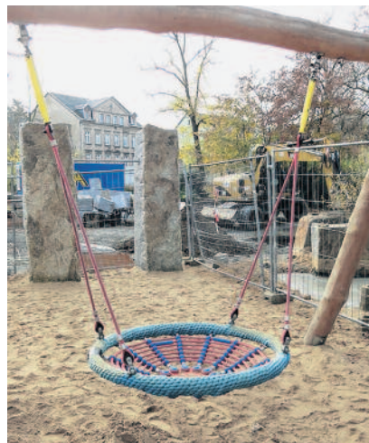
zum 20. März ist eine Winterpause geplant, wo die Arbeiten ein letztes Mal unterbrochen werden. Foto: S. Eberbach
