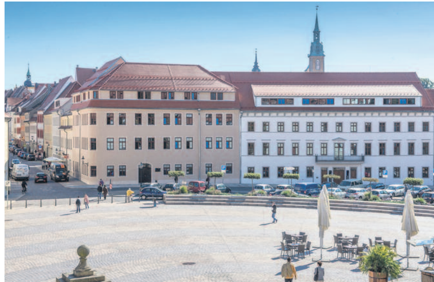
Ein weiterer Eckpfeiler des Wissenschaftskorridors zwischen Altstadt und Campus wurde mit dem 1. Bauabschnitt des Schlossplatzquartiers fertiggestellt. Foto: Detlev Müller
