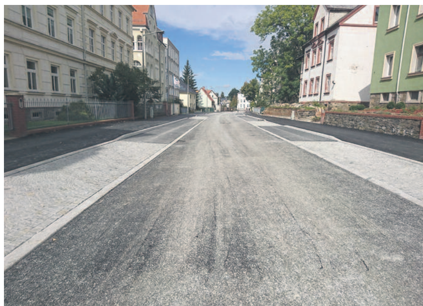
„Freie Fahrt“ heißt es seit Anfang November wieder auf der Silberhofstraße: Nach sechs Monaten Bauzeit ist der Baubereich von der Einmündung Frauensteiner Straße bis einschließlich Kreuzung Schönlebestraße wieder für den Verkehr freigegeben. Foto: Simone Lohse
