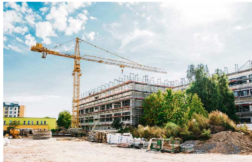
Es geht voran auf dem Bau an der Ohain-Schule: In der Mitte zu sehen ist der Neubau, rechts schließt das Bestandsgebäude an. Foto: 599 media/P. Schmidt
