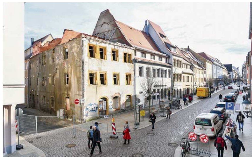
Ein Schandfleck: das ruinöse Gebäude Burgstraße 38. Für das Gebäude in exklusiver Innenstadtlage gibt es nun Rettung. Die SWG hat es erworben und stoppt den weiteren Verfall zunächst mit einem Notdach.
