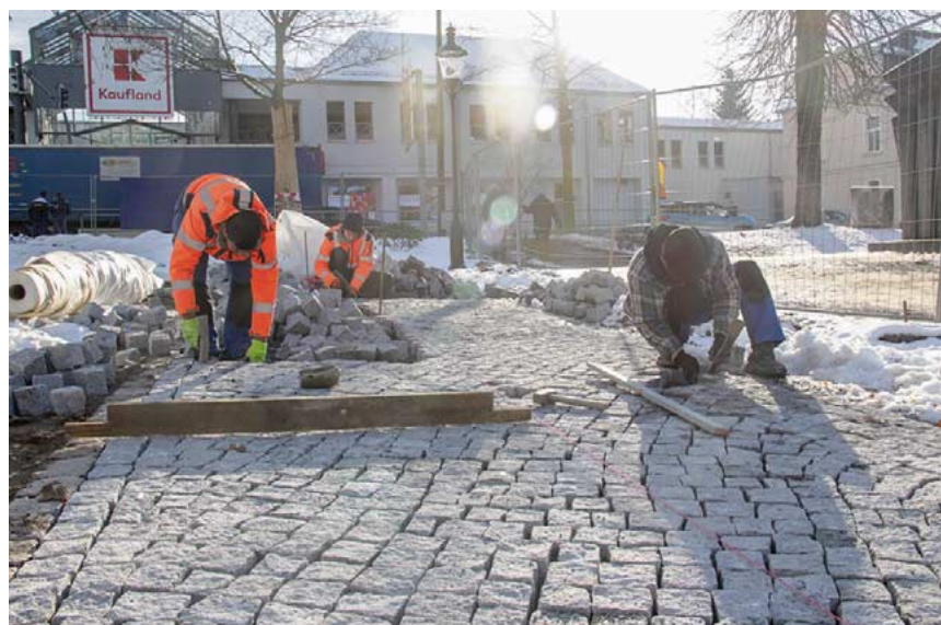
Der Fußweg in der Parkanlage am Bebelplatz soll in diesen Tagen fertig gestellt sein.
