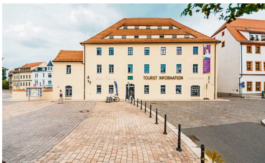
Die Tourist-Information im Silbermannhaus auf dem Schloßplatz darf nun das „rote i“ tragen. Foto: 599media/Paul Schmidt
