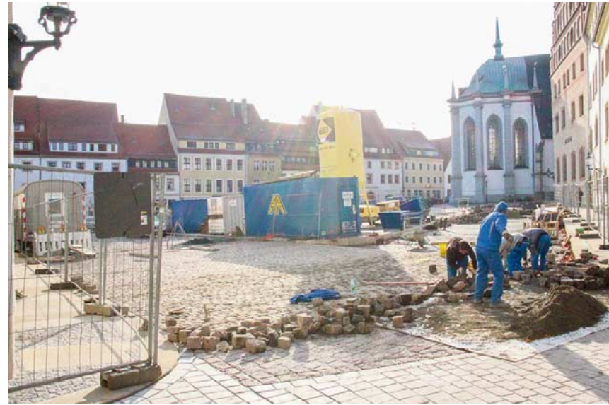
Baugeschehen auf dem Untermarkt: Letzte Pflasterarbeiten vor dem nahenden Winter. Kommen die Arbeiten gut voran, könnten bis zum Weihnachtsfest die ursprünglichen Zufahrten zum Parkplatz auf dem Marktplatz wieder nutzbar sein. Foto: se
