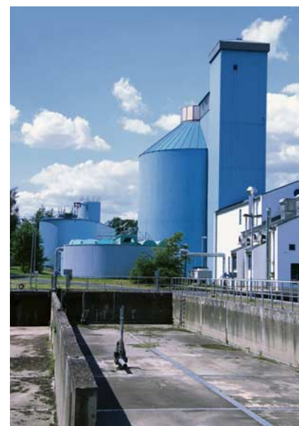
Faulturm (203): Zur Energieerzeugung wird das Gas aus dem Klärschlamm genutzt.
