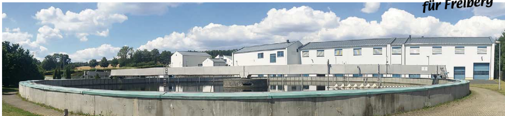
Mit Durchmessern von 50 Metern fassen die beiden Nachklärbecken (116) insgesamt 20.000 Kubikmeter. Im Hintergrund: das Betriebsgebäude (402).
