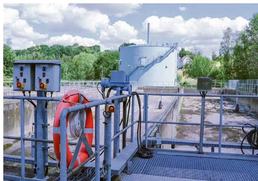
Platz für über 2.000 Kubikmeter Wasser im Wartungs- oder Havariefall bietet der Abwasserspeicher (102), im Hintergrund der Gasspeicher (301). Fotos: PS
