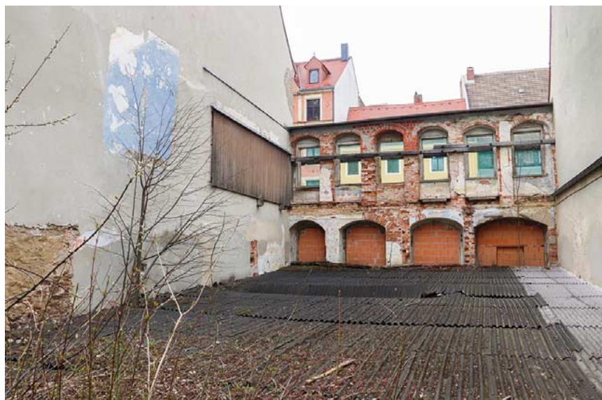
Blick von hinten auf die Petersstraße 19: Hier ist viel Platz für das künftige Freiburger Welterbe-Besucherzentrum. Foto: Christian Möls
