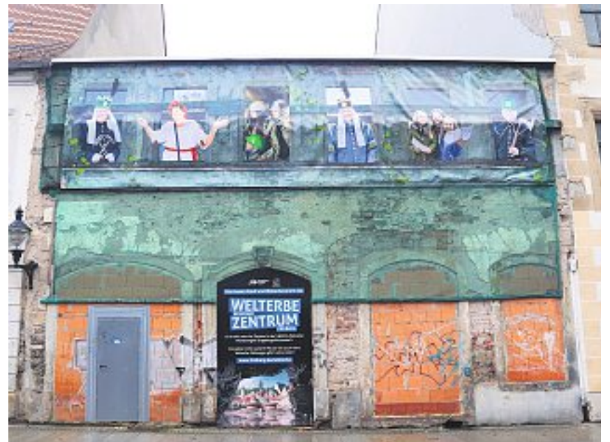
Bald soll sie ein Blickfang sein: die Fassade des künftigen Welterbe-Besucherzentrums auf der Petersstraße. Denn sie soll, wenn sie saniert ist, begrünt werden. Foto: Archiv PS
