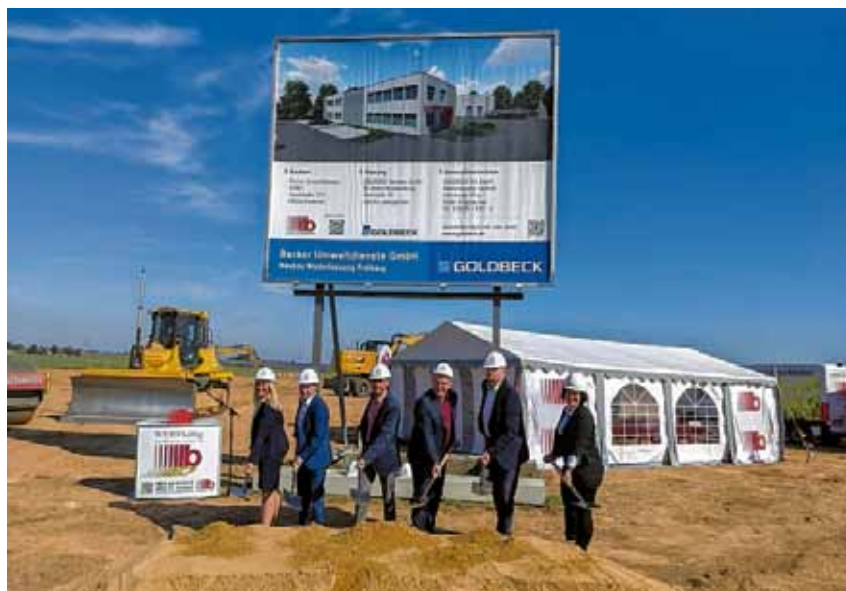
Der erste Spatenstich für den neuen Firmenstandort der Becker Umweltdienste GmbH im Gewerbegebiet Freiberg Ost. Im Sommer 2024 sollen der neue Verwaltungs- und Sozialtrakt sowie ein erweiterter Logistikpark entstehen. Foto: Stadt Freiberg
