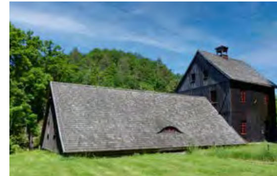
6 IV. Lichtloch mit Treibehaus und Radstubenkaue sowie Teilen der Förderanlagenbauten
