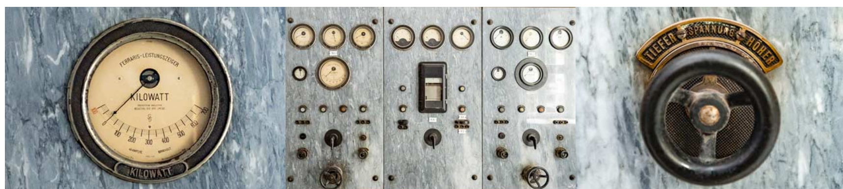
Fotos unten v.l.n.r.: Leistungs- messinstrument, Bedienele- mente und Spannungsteller zur Fernübertragung in 272 Meter Tiefe
