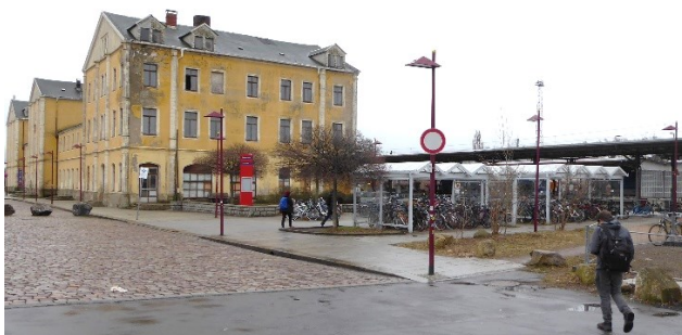
Abbildung 2: Bahnhof Freiberg mit Vorplatz
