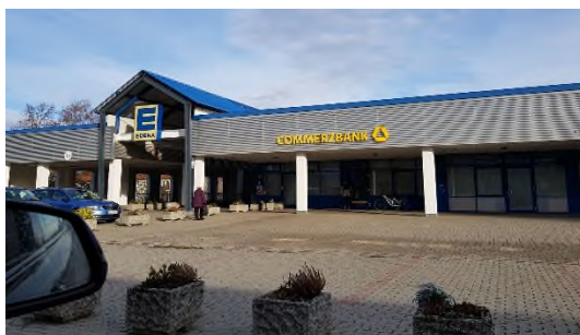
Foto 8: NVZ Karl-Kegel-Straße, nördliche Immobilie
