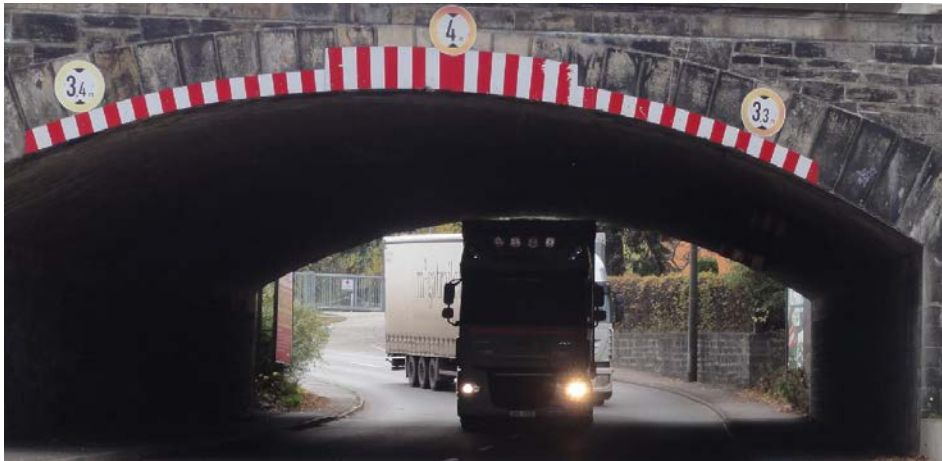
Foto: Lkw bei der mittigen Durchfahrt einer in den Seitenbereichen niedrigen Eisenbahnunterführung an der B 101 Olbernhauer Straße
