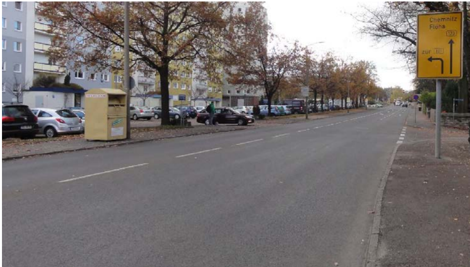
Foto: B 173 Chemnitzer Straße vor der zwischenzeitlich erfolgten Markierung von Radschutzstreifen: zu breite Fahrbahn für nur zwei Richtungsfahrbahnen
