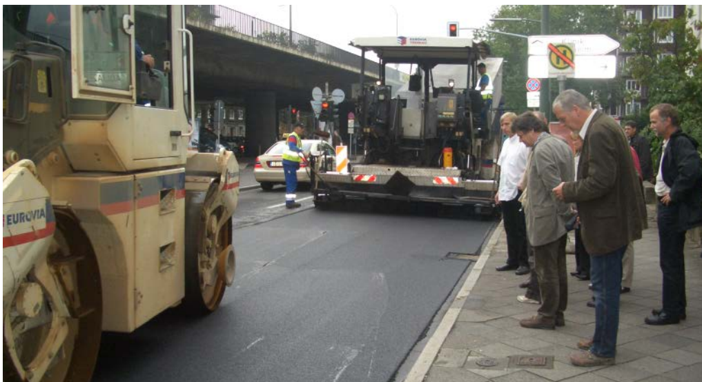
Foto: Einbau eines lärmoptimierten Asphaltes in Düsseldorf
