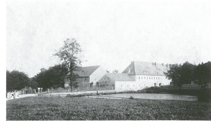
Lessingstraße 53, Blick auf das Seitengebäude und die Scheune, Aufnahme um 1910
