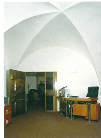
Lessingstraße 53, Erdgeschoss, Kreuzgratgewölbe, Aufnahme 2007
