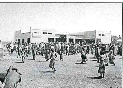
Endlich Strom dank einer sächsischen Anlage: Das Gesundheitszentrum Kolombo, gebaut durch die Freiburger Partnerstadt Gentilly, erhält seinen Strom seit diesem Frühjahr aus einer Solarstromanlage - im Bild bei der Inbetriebnahme. Fotos (3): AV
