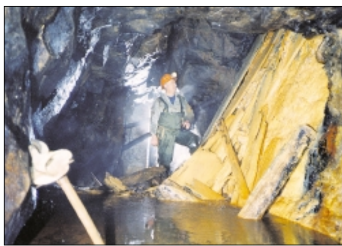
Der Alte Tiefe Fürstentoll: Sein Grubenwasser soll künftig zur Klimatisierung des Schlosses genutzt werden. Foto: Andreas Benthin
