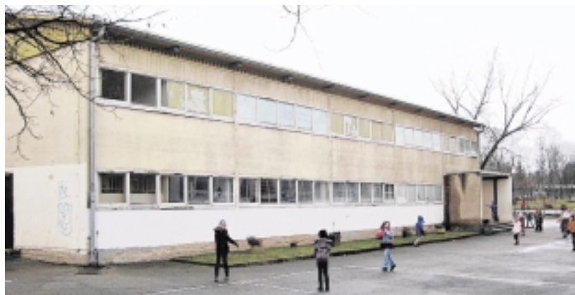
Auch die Turnhalle wird abrisen und neu gebaut. Fotos (2): Walter Gutmann
