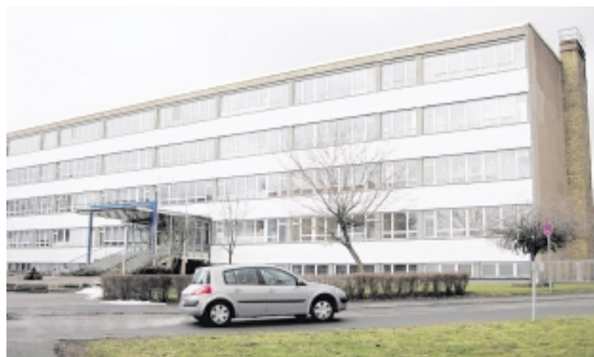
Hier hat der Abriss bereits begonnen: an der Günzel-Schule auf dem Seilerberg. Bis Ende nächsten Jahres soll der Ersatzneubau bezugsfertig sein.
