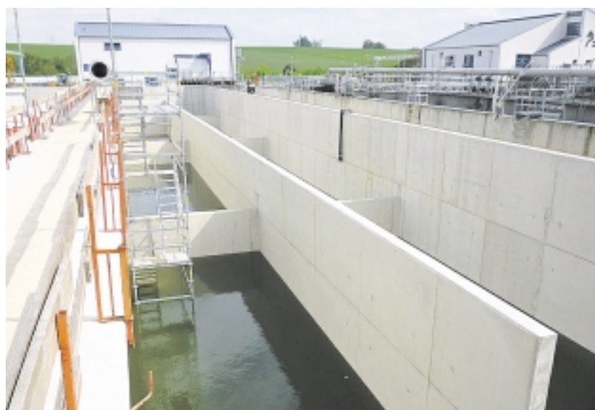
Dichtheitsprüfung: Dafür ist das Belebungsbecken der Zentralkläranlage erstmals gefüllt worden ... und bestand die Prüfung.
