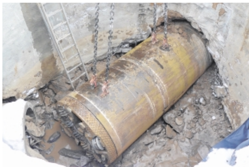
Abschnitt geschafft: Hier kann die Vortriebsmaschine bereits ausgebaut werden - und kann zum nächsten Einsatzort transportiert werden. Fotos (2): FAB
