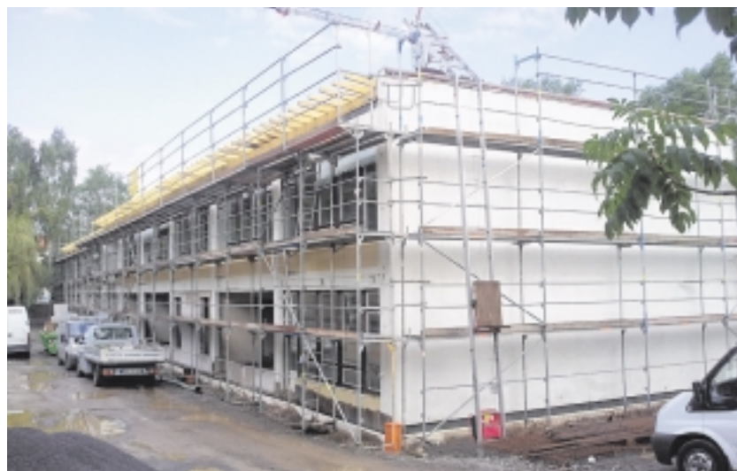
Sanierung und Erweiterung der Kindertagesstätte „Kinderland“ am Franz-Kögler-Ring 137.
