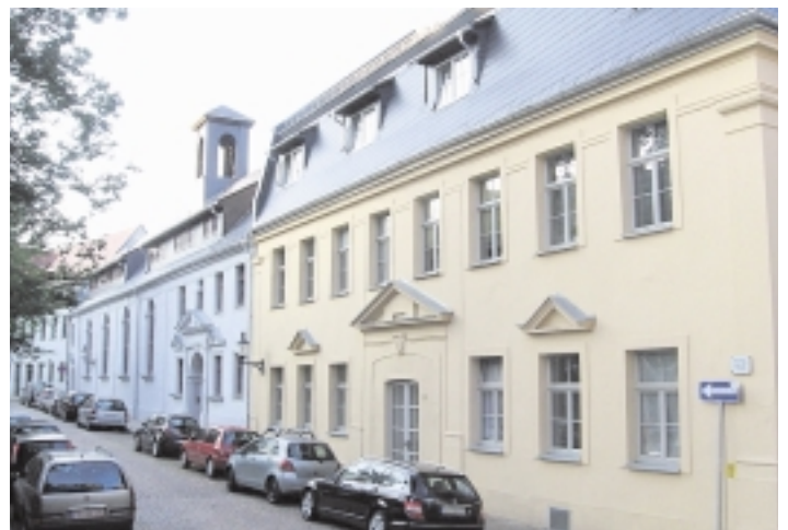
Die Gebäude der ehemaligen katholischen Kirche in der Kreuzgasse sind zu einer Wohnanlage umgebaut worden. Dafür erhält der Bauherr den Freiburger Sanierungspreis 2010.
