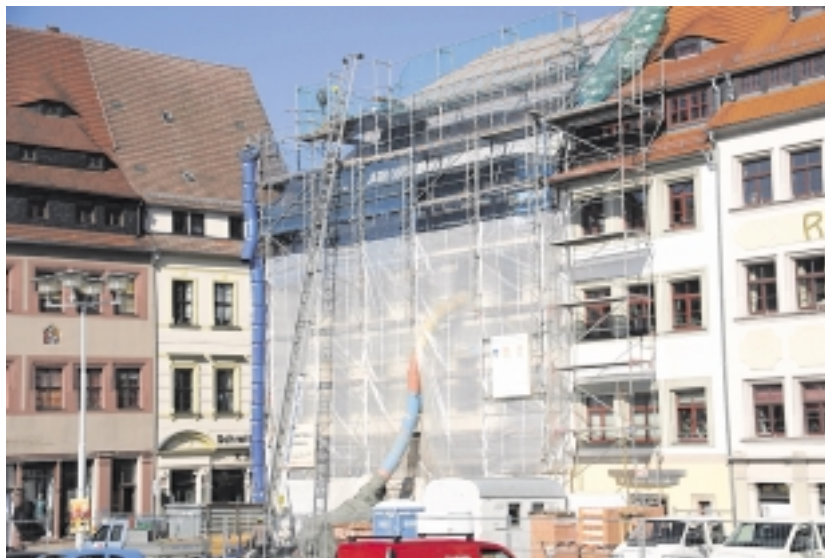
Nicht zu übersehen: die Bautätigkeit am Gebäude Obermarkt 21. Im Mai nächsten Jahres soll es fertig sein. Foto: Anett Stromer
