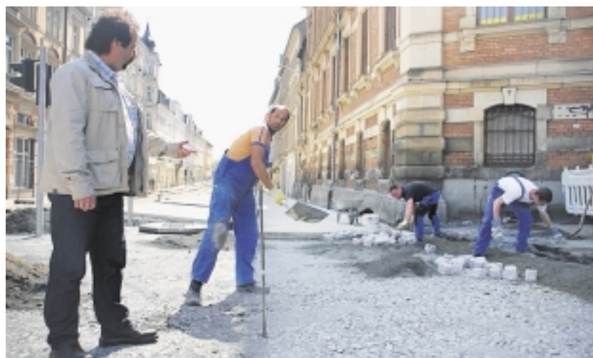
Die Verlegearbeiten auf der Poststraße waren kurz vor Ostern schon weit vorangeschritten. Im Bild Rolf Rothermundt (li.), Mitarbeiter im Sachgebiet Straßen- und Brückenbau der Stadtverwaltung, und Mitarbeiter der Vogtländischen Straßen-, Tief- und Rohrleitungsbau GmbH Rodewisch. Foto: PS
