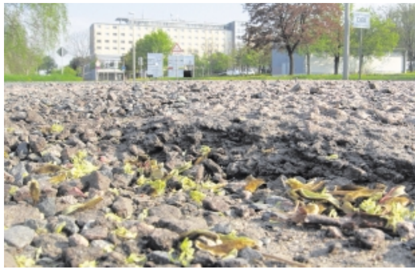
Loch an Loch: Damit soll es bald vorbei sein. Seit gestern laufen die Bauarbeiten auf der Halsbrücker Straße. Foto: PS
