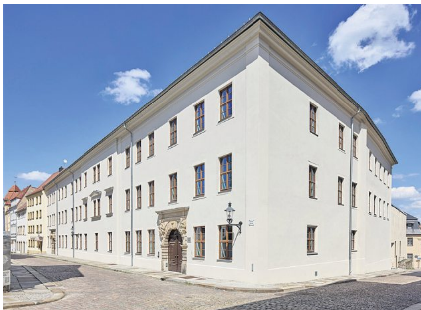
Stadtbildprägend: das sanierte Herderhaus in der gleichnamigen Straße. Es ist ab jetzt das neue Domizil des Freiburger Stadtarchivs. Fotos (2): Jan Gutzeit
