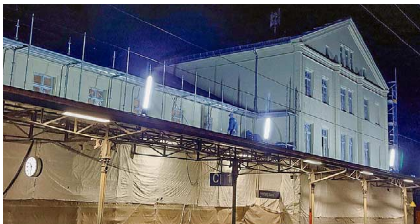
Die ersten Gerüste sind am Bahnhofsgebäude abgebaut.
