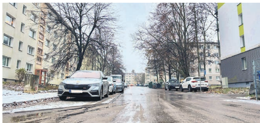
Wieder freie Fahrt auf der frisch sanierten Maxim-Gorki-Straße.
